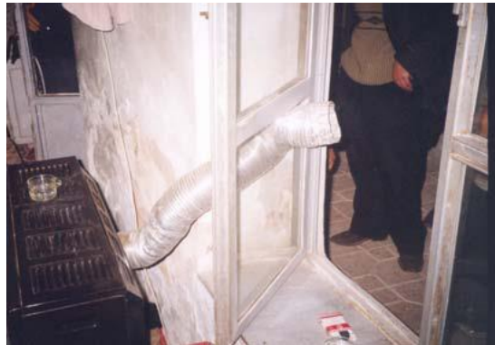
نمونه دودکش های نامناسب کار گذاشته شده در منازل
